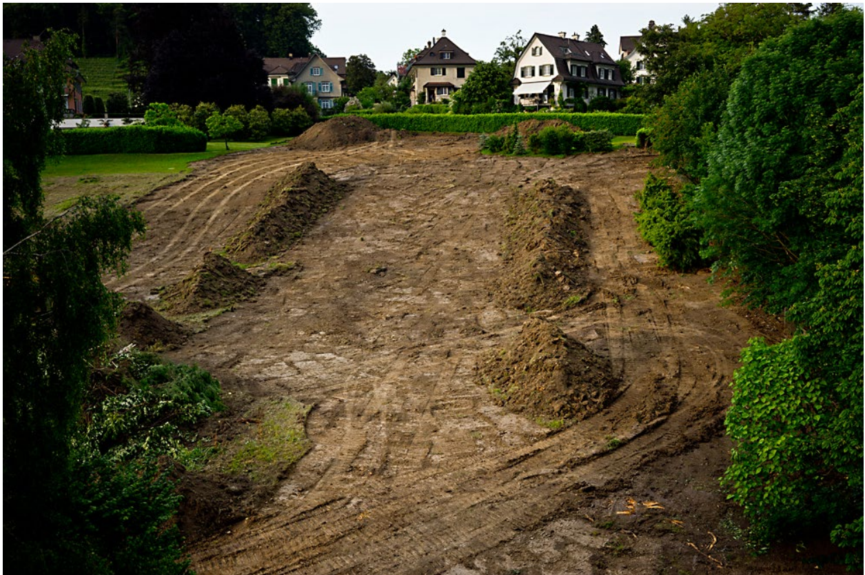
Beginn einer Baustelle – Zollikerstrasse über dem Bahnhof Tiefenbrunnen in Zürich. (Dienstag, 4. Juni 2014)
