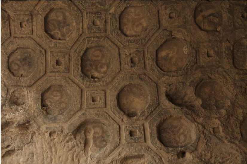
Eine komplexe Kassettendecke in der Omfa-ca. Gut sichtbar sind da und dort noch die Spuren der gemalten Triskels, die jede der achteckigen Kassetten zierten.
