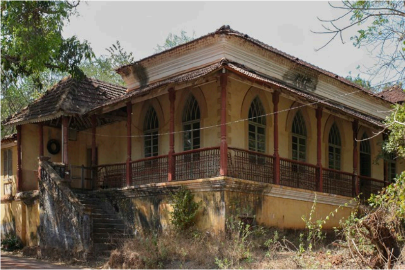
Viele der ehemals prachtvollen Villen von Senpuav sind in einem desolaten Zustand.
